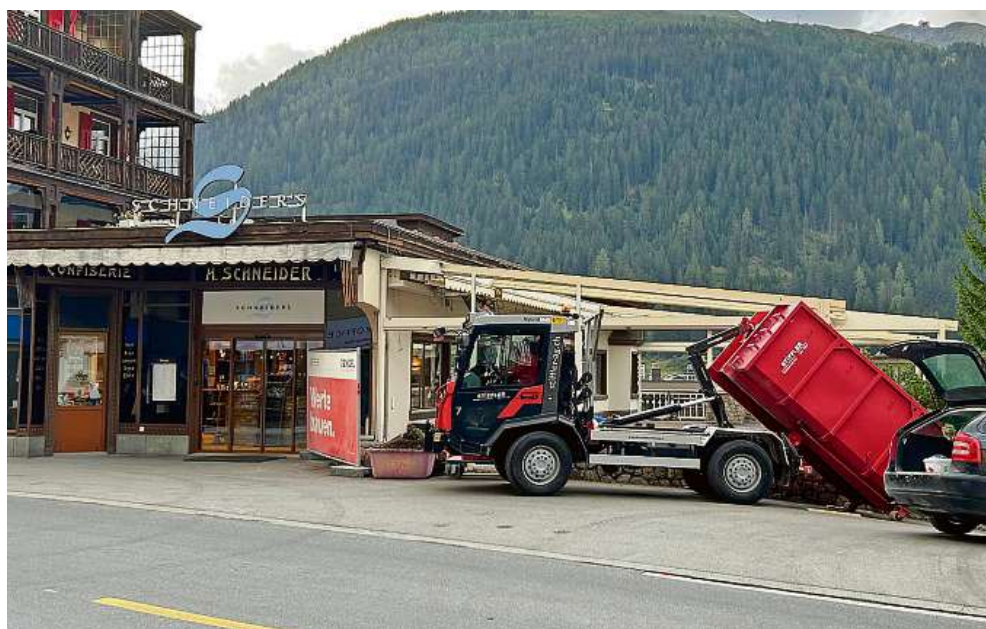
Die Bauarbeiten für die Terrasse haben bereits begonnen.
